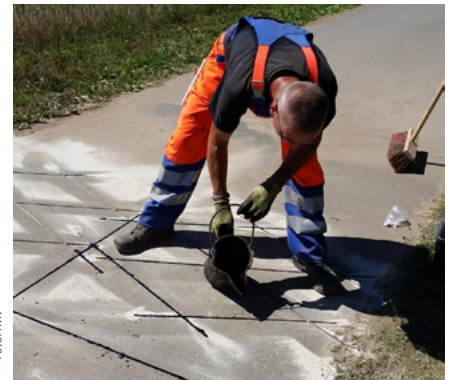
Installation des Radzählgerätes bei Brook
