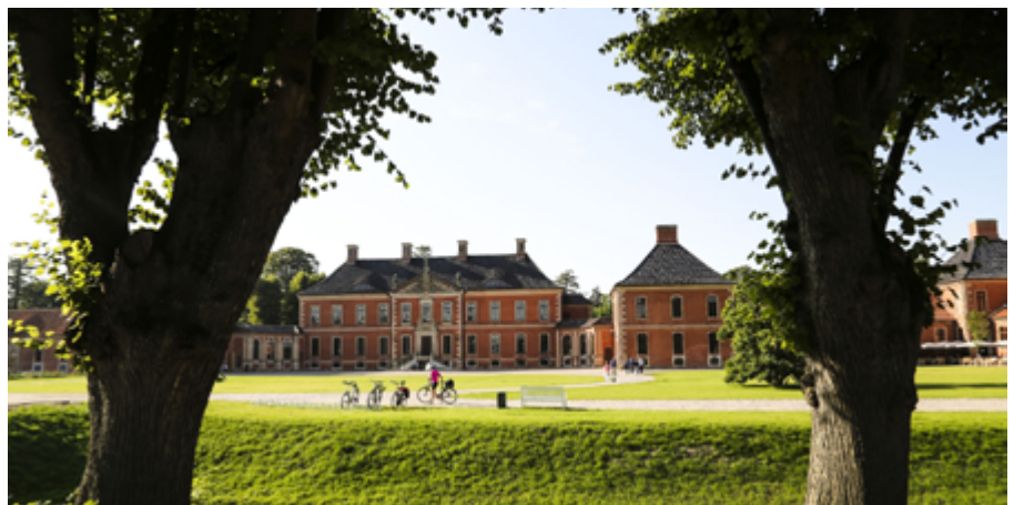
Schloss Bothmer, 2015 nach Sanierung wiedereröffnet
