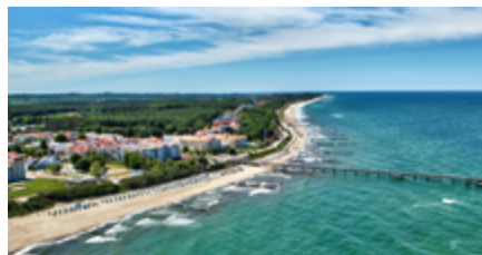
Luftaufnahme der Seebrücke Kühlungsborn
